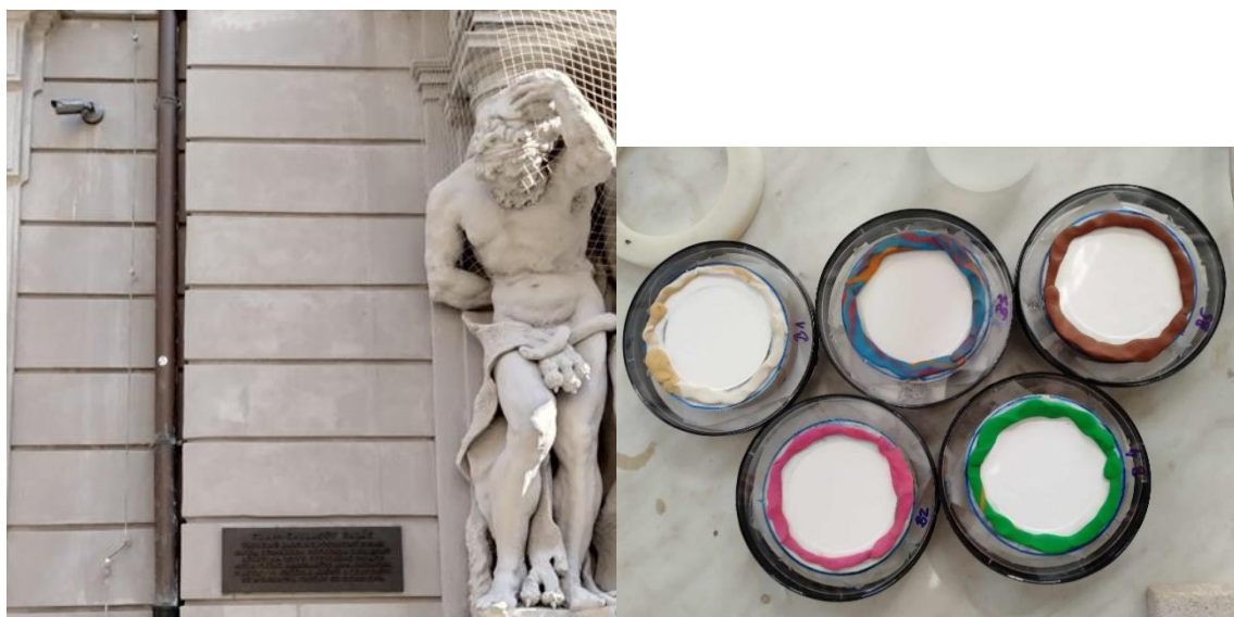
Obrázek 1 Vlevo: Clam-Gallasův palác, pohled z Husovy ulice. Na fasádě jsou vidět skvrny. Vpravo: vzorky připravené na měření odparu.
