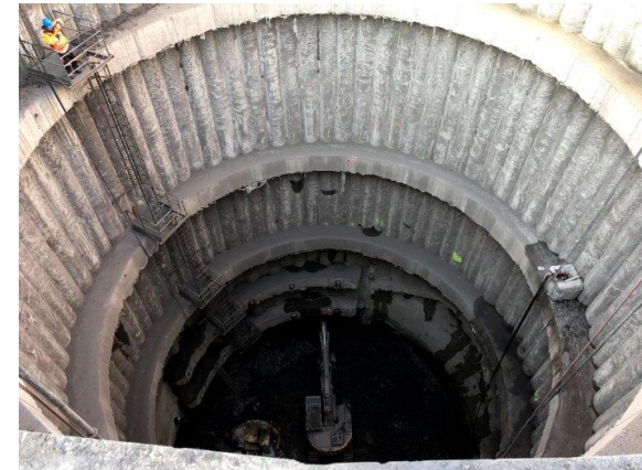
Průzkumná šachta metra D – využití stříkaného betonu s pojivem Sorfix patentovaným VŠCHT a partnery
